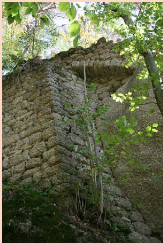
Mauertorso (li.) und Ringmauer mit Entlastungsbogen (re.)
