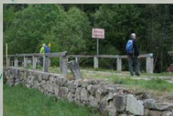
Die Steinerne Brücke über die Malsch und Staatsgrenze
