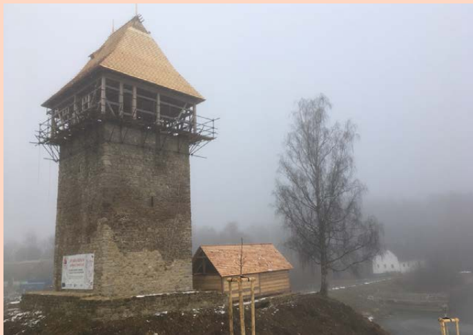
Beim quadratischen Hauptturm wird ab 2020 der Fachwerkstock samt Dach rekonstruiert
