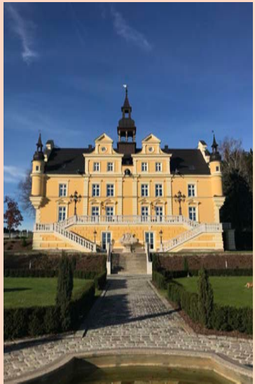
Die heutige Ansicht von Schloss Tannbach nach der gelungenen Renovierung
